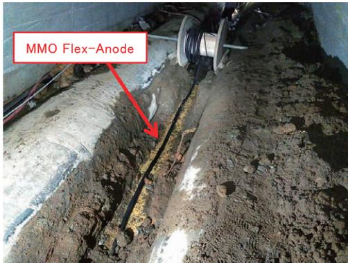
図 10 電極設置状況
