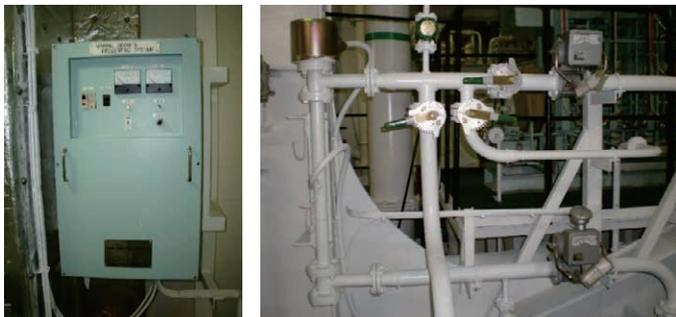
図1 MGPSの電源装置と電解槽
