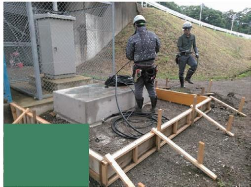
図 13 配線布設状況(直流電源装置付近)
