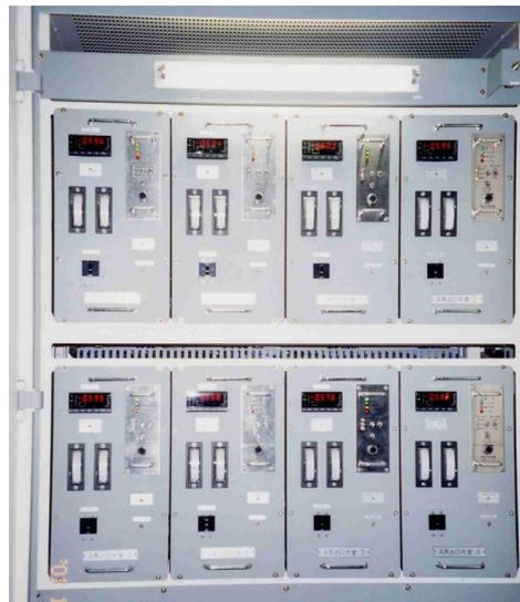
写真1 電気防食制御盤正面パネル(ユニット電源装置が8台並んでいる。)
