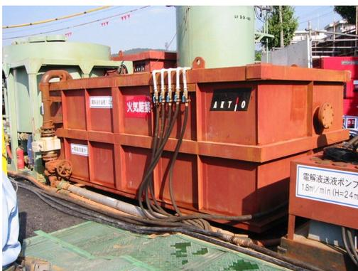
写真4 電解液貯留槽
