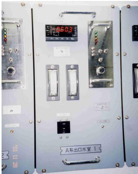
写真2 ユニット電源正面パネル
