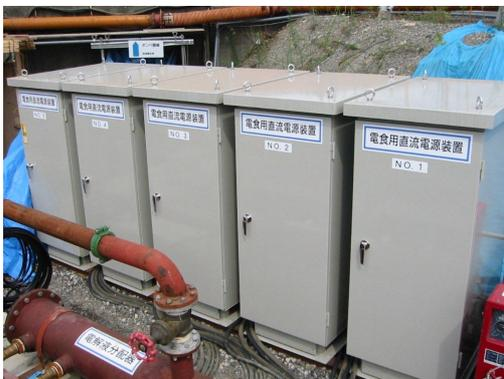
写真3 直流電源装置
