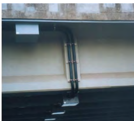
モルタル被覆後
