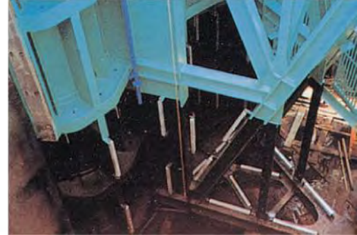
水門に対するアラノード（アルミニウム陽極）の取付状況
